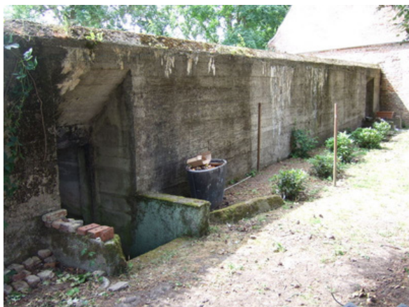
Longueur du bunker (G. Rommelaere)
